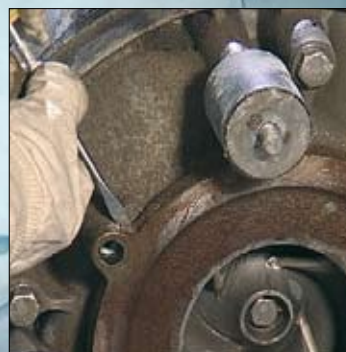
Einfache Wartung Gesamtwartung aller Pumpen
