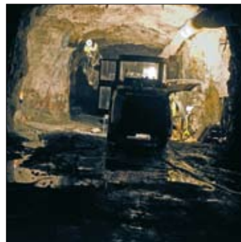
Bergbau und Tunnelbau
